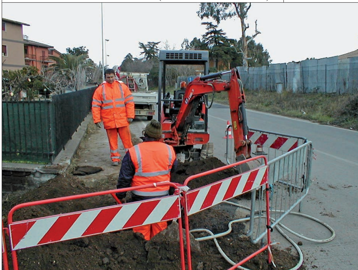
Lavoratore a terra in condizioni di sicurezza (manoperatore fuori della cabina)
