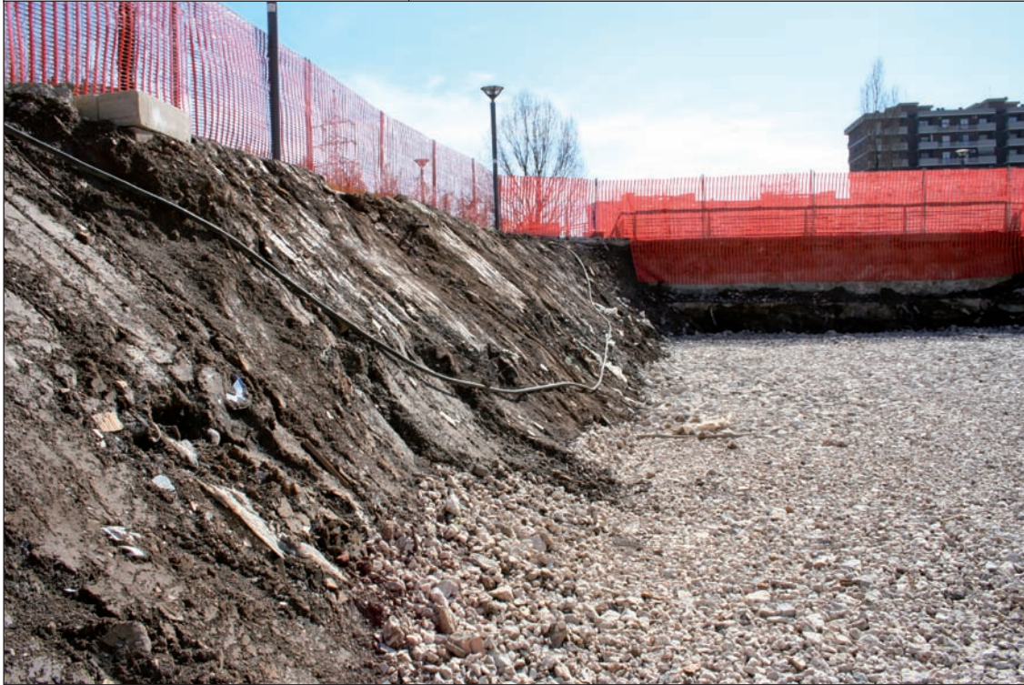
Profilo di scavo a stabilità naturale
