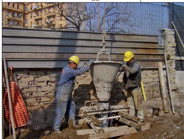
Inserimento della tramoggia-imbuto
