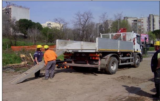
Rimozione seconda pedana
