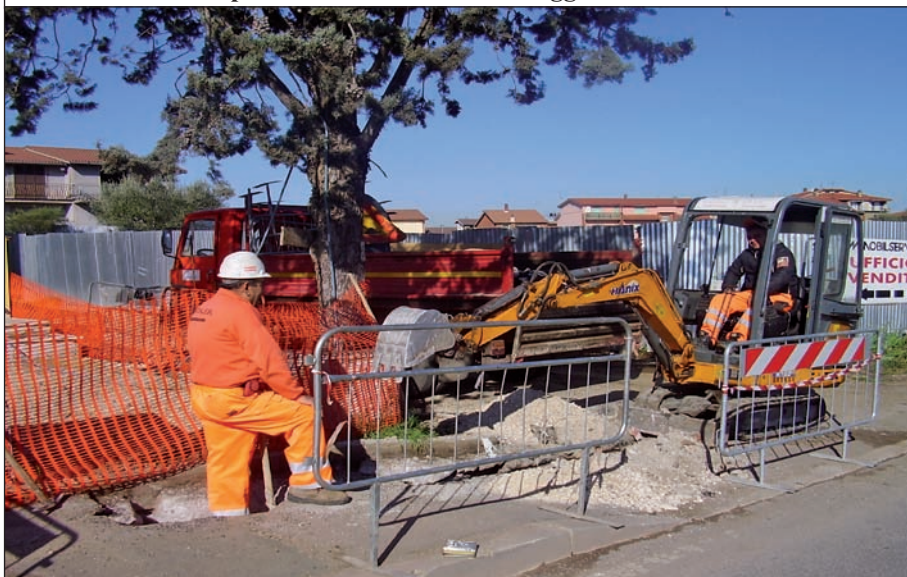
Scavo stradale – Operatore a terra fuori del raggio di azione dell'escavatore
