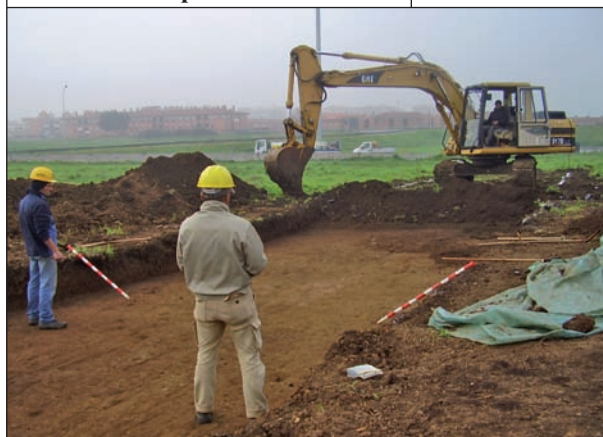
Escavatore in posizione di blocco
