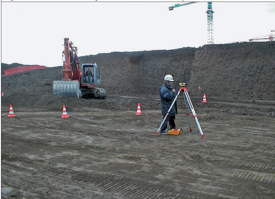
Separazione di attività durante operazioni di movimento terra
