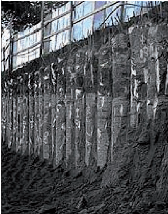
Profilo di scavo contenuto con palificazione
