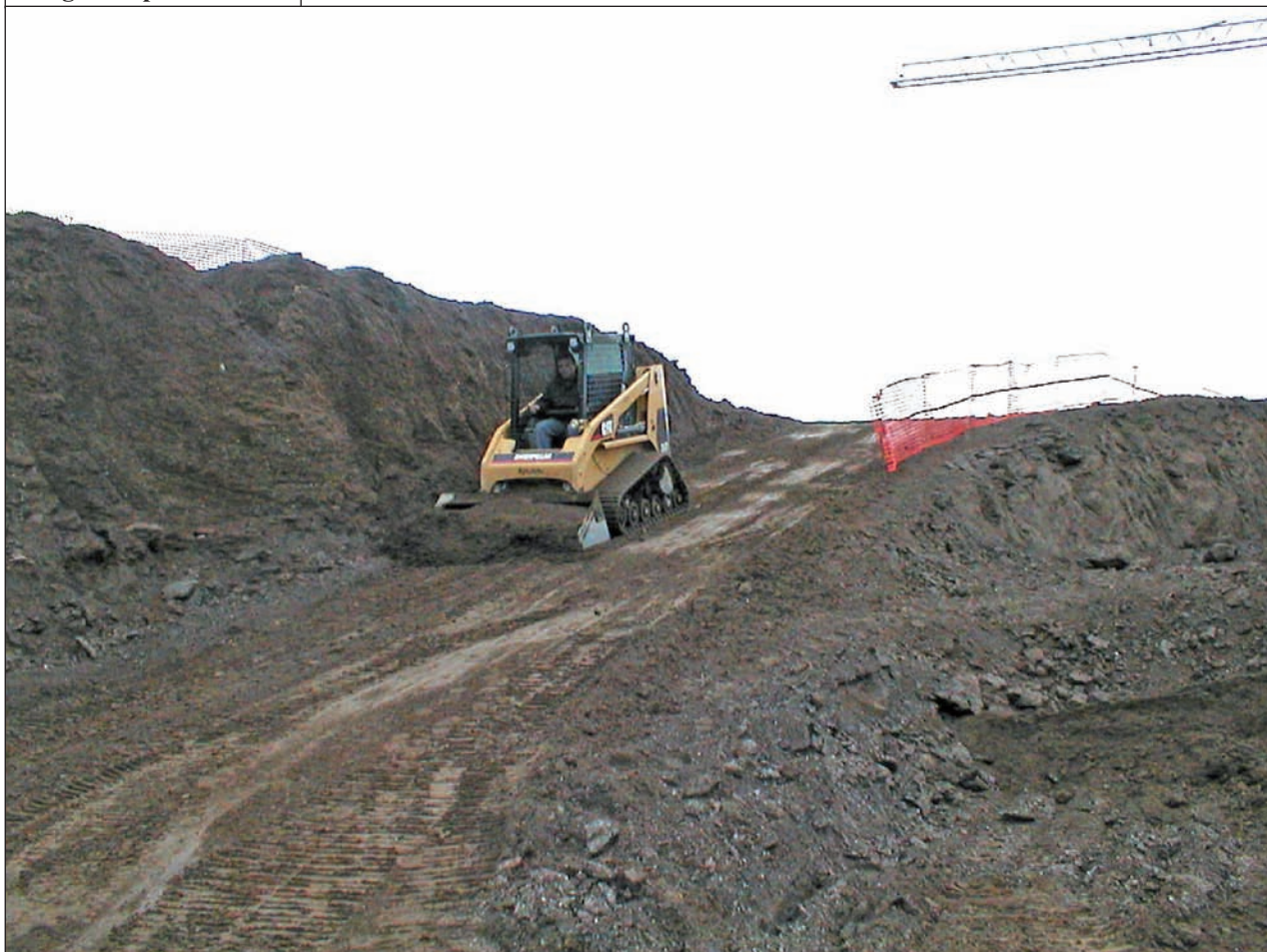
Larga rampa di accesso
