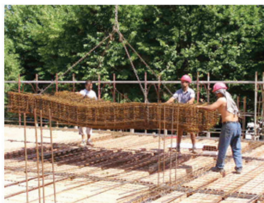
Immagine 23 sollevamento reti elettrosaldate e posa travetti nella zona di appoggio
