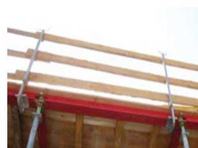
Immagine 21 parapetto perimetrale
